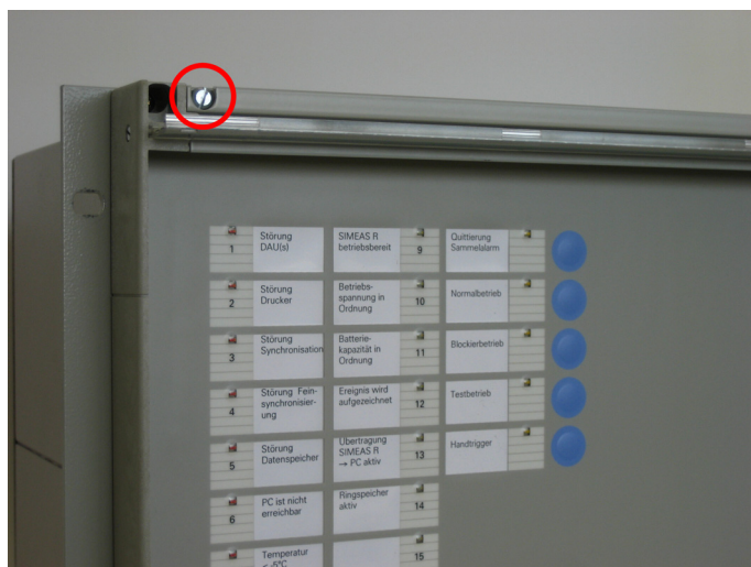
Bild 1-1 Abdeckrahmen lösen
