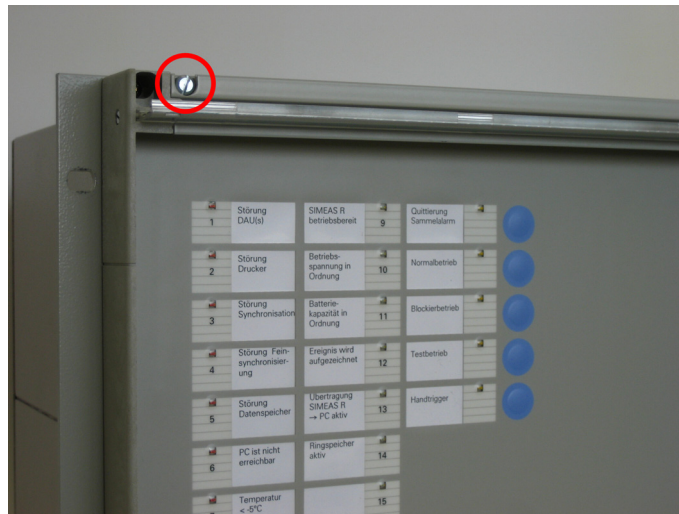
Bild 2-1 Abdeckrahmen lösen
